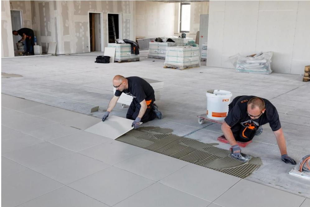
Bild 5: Nach dem Auftragen des Verlegemörtels werden die Fliesen mit leicht schiebender Bewegung im Kleberbett angesetzt und ausgerichtet.
