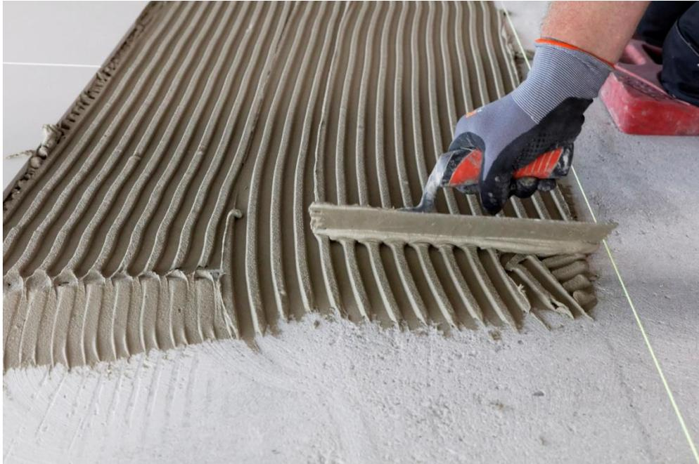
Bild 3: Mit einer Zahntraufel tragen die Handwerker den PCI Flexmörtel S2 auf den grundierten Untergrund auf. Wichtig dabei: Nur so viel Mörtel aufkämmen, wie innerhalb der klebeoffenen Zeit mit Fliesen belegt werden kann.
