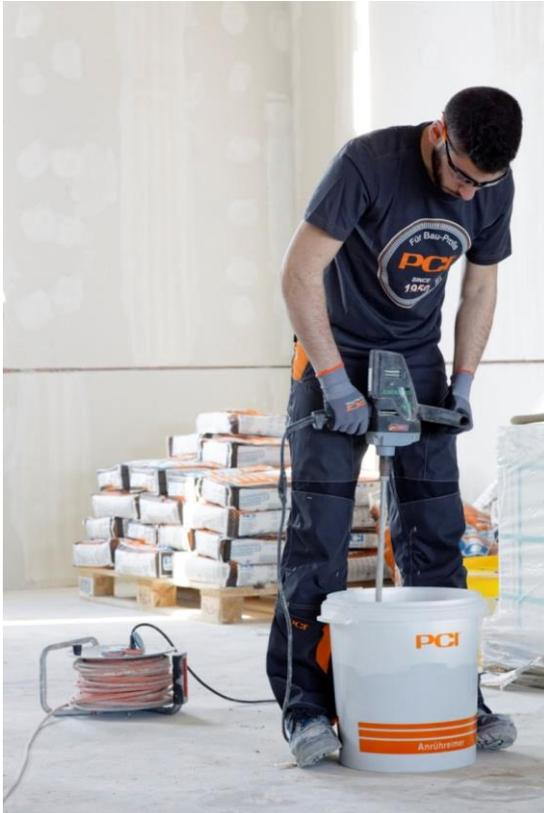
Bild 2: Fliesenverlegung mit dem Fliesenkleber PCI Flexmörtel S2: Das Pulver wird in das Anmachwasser gegeben und mit einem Rühr- oder Mischwerkzeug zu einem plastischen, knollenfreien Mörtel angerührt. Nach rund drei Minuten Reifezeit und nochmaligem kurzem Aufrühren lässt sich der Fliesenmörtel dank der geschmeidigen Konsistenz einfach verarbeiten.
