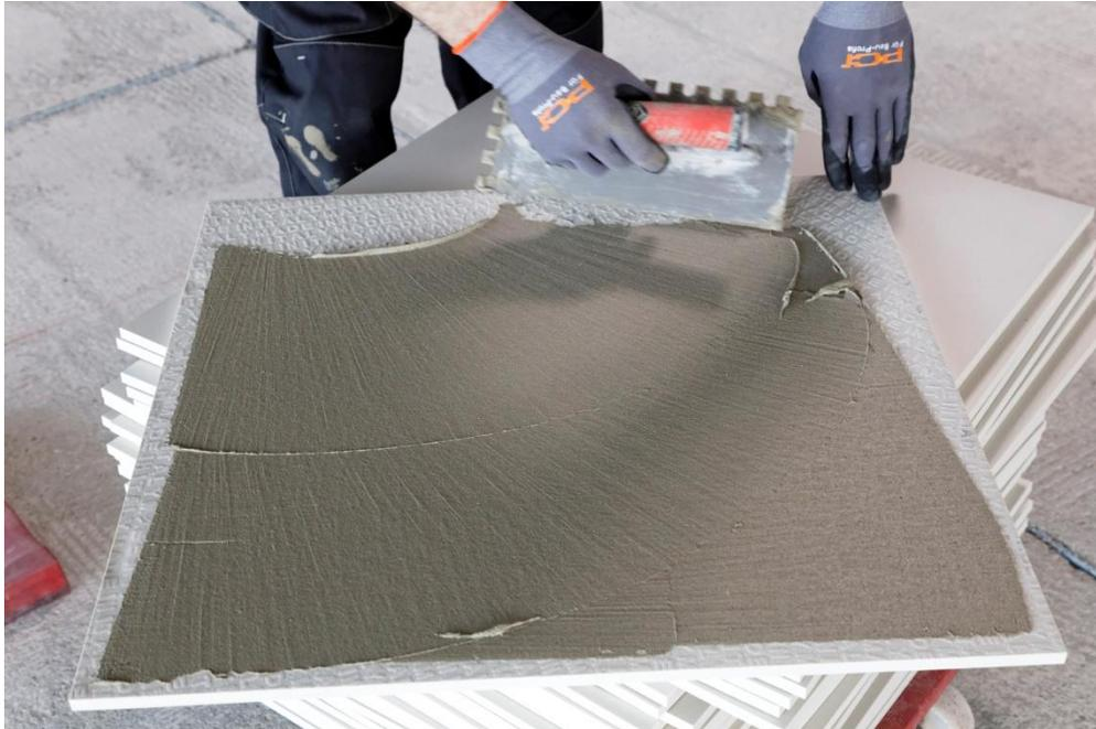
Bild 4: Mit der glatten Seite der Zahntraufel ziehen die Fliesenleger eine dünne Mörtelschicht auf die Rückseite der großformatigen Fliesen auf. Das beidseitige Auftragen des Fliesenmörtels verhindert Hohllagen und trägt zu einer besseren Haftung der Fliesen auf dem Untergrund bei.
