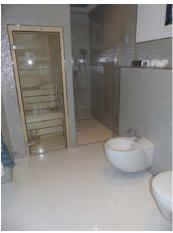
Bild 3 und 4: Rund 40 m² der Wandflächen im Bad verlegten die Handwerker mit großformatigen Wandfliesen im Format 33 x 100 cm.
