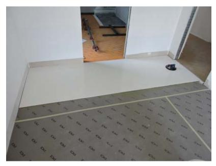
Bild 7: Zum Spannungsabbau verlegten die Handwerker unter den Fliesen die Entkopplungsmatte PCI Pecilastic E mit dem verformungsfähigen PCI Flexmörtel S1 Flott. Im Bad kam die Abdichtungs- und Entkopplungsbahn PCI Pecilastic U zum Einsatz.
