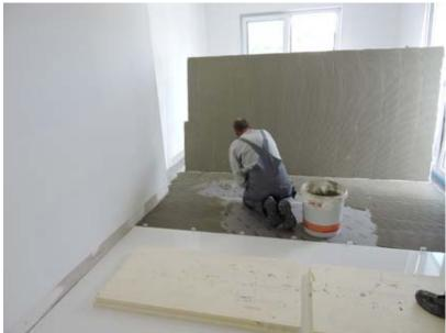
Bild 5 und 6: Um eine weitestgehend hohlraumfreie Verlegung der großen Feinsteinzeugfliesen zu erzielen, spachtelten die Fliesenleger den Fliesenkleber PCI Flexmörtel S1 Flott auf den vorbereiteten Untergrund und auf die Fliesenrückseite auf.
