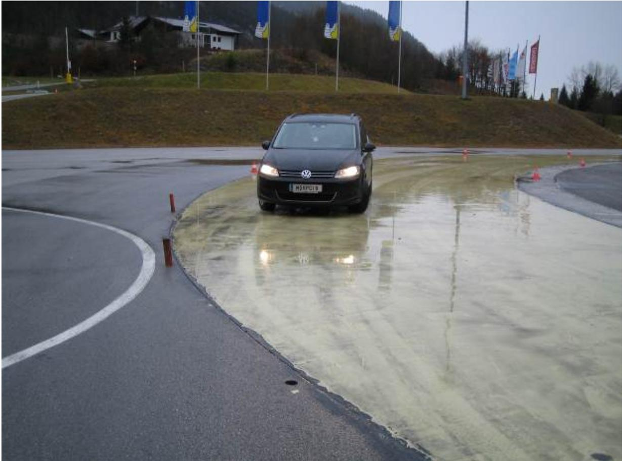
Auf der nassen Schleuderstrecke werden schwierige Verkehrsverhältnisse simuliert, beispielsweise das Fahren auf einer vereisten Straße. Deshalb braucht die Fahrbahn eine spezielle Beschichtung, die im Fahrtechnikcenter in Saalfelden mit der PUR-Beschichtung PCI Apoten PU erstellt wurde.
