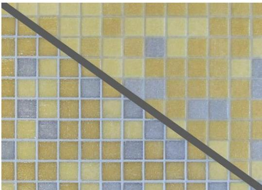
Fläche verfugt mit zementären Fugenmörtel und mit PCI Durapox<sup>®</sup> Premium Harmony (Link zum hochauflösenden [Photo](#))
