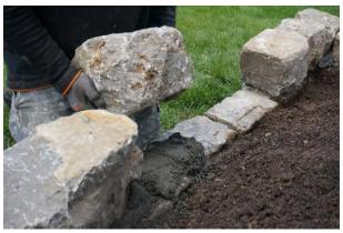
Dank einer Mörtelbettdicke von 5 bis 40 mm und trasshaltiger Rezeptur ist PCI Carraroc der ideale Bettungsmörtel für das Setzen und Fixieren von Natursteinmauern und Hochbeeten (Link zum hochauflösenden <u>Photo</u>)
