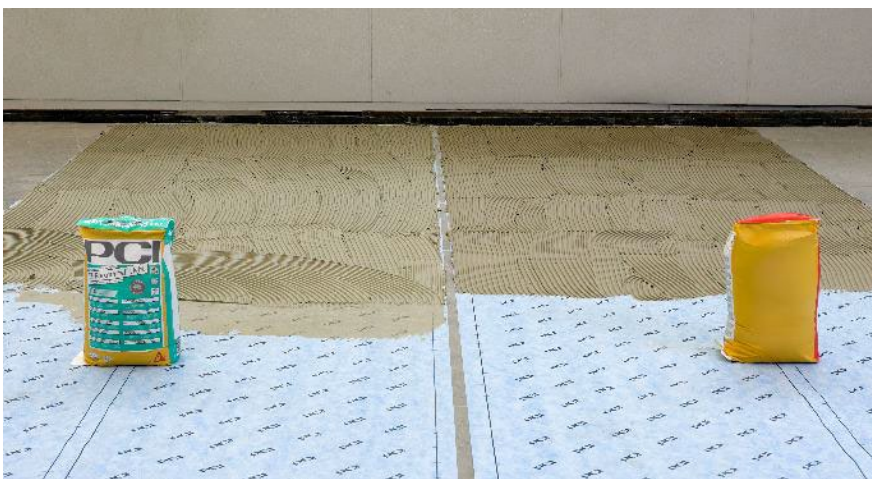
PCI Flexmörtel Light: Live-Demonstration belegt Kernaussage ‚halbes Gewicht – gleiche Fläche‘ ( Link zum hochauflösenden Photo)
