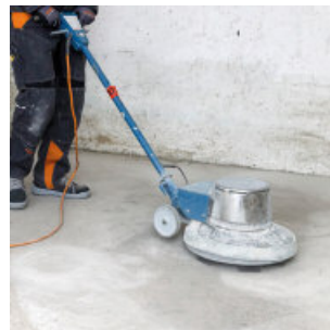
Boden abschleifen
