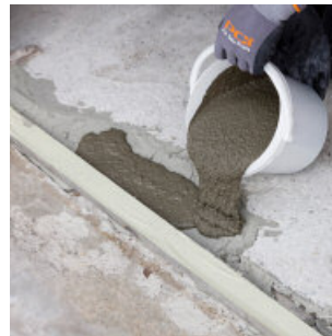
Einfahrtsschiene mit fließfähigem Mörtel hintergießen
