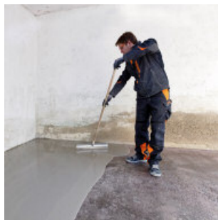
Beschichtung verteilen
