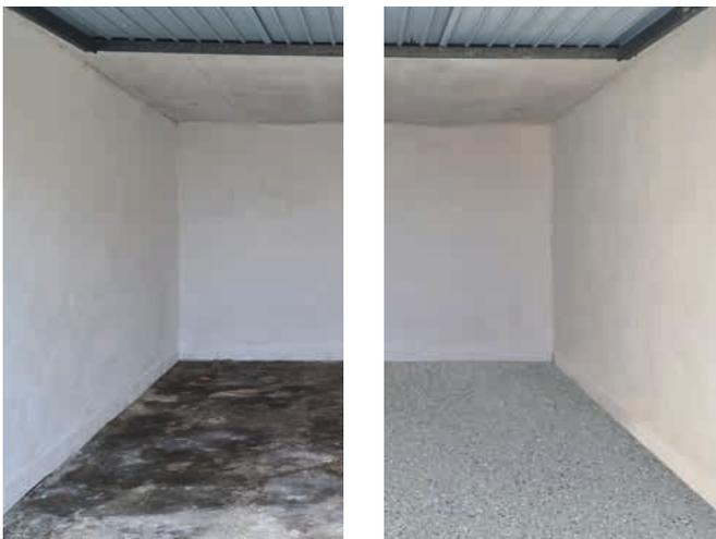
Garagen bieten Werten wie Fahrzeugen Schutz. Aber wie schützt man Garagen? Ob durch mechanische Belastungen beim Befahren, Hitze und Frost, Nässe, Tausalz oder Ölablagerungen: Im Laufe der Zeit nimmt unversiegelter Estrich bzw. Betonboden zwangsläufig Schaden.
