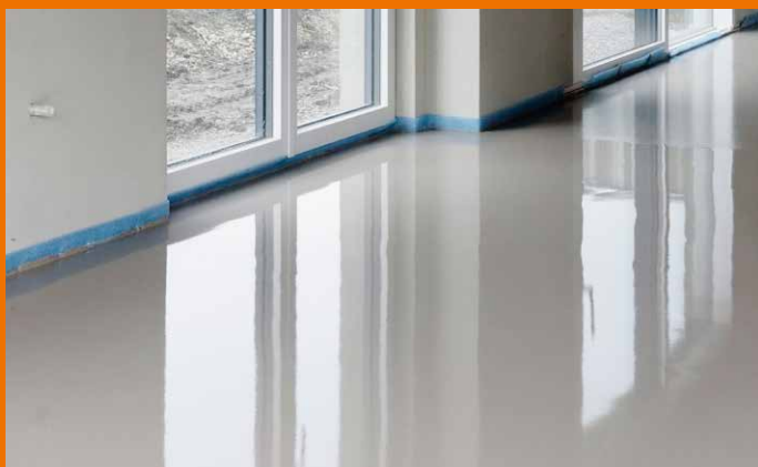
Perfektes Ergebnis: Eine porenarme, sehr glatte Oberfläche, die kein zusätzliches Nachschleifen erforderlich macht.
