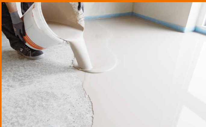
Entspanntes Arbeiten: Anrühren – Ausgießen – Läuft!
