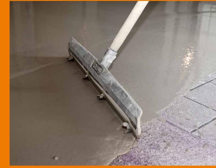
Mit einem Stift- oder Kufenraket lassen sich die Spachtelmassen der PCI Periplan-Familie angenehm im Stehen verteilen.
